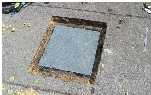
obr. /3/ Pohled na zapravení spodního souvrství asfaltových pásů v místě sondy S01
