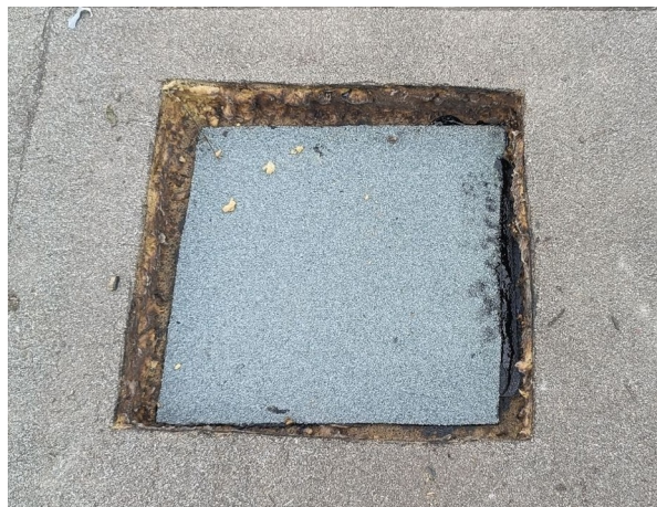
obr. /7/ Pohled na zapravení spodního souvrství asfaltových pásů v místě sondy S02
