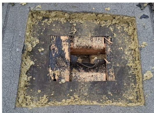
obr. /2/ Pohled do sondy S01 po jejím provedení
