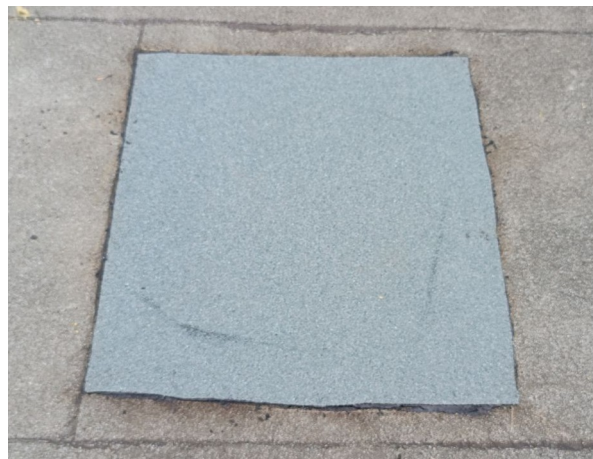
obr. /8/ Pohled na zapravení horního souvrství asfaltových pásů v místě sondy S02
