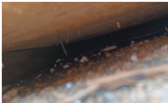
obr. /12/ Pohled na stav dřevěných prvků v místě provedené sondy S02
