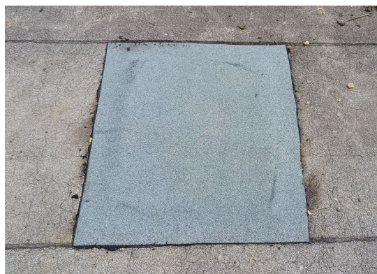
obr. /4/ Pohled na zapravení horního souvrství asfaltových pásů v místě sondy S01
